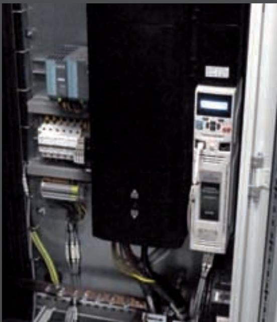
I motori a magneti permanenti sono controllati tramite un azionamento a velocità variabile della famiglia Unidrive M700 di Control Techniques. *Permanent magnet motors are controlled by a Control Techniques Unidrive M700 variable speed drive.*
